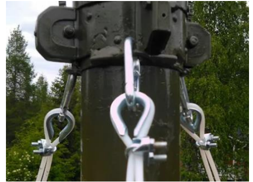
Рисунок 9 – Узлы крепления такелажа для растяжки мачты ВГ.
