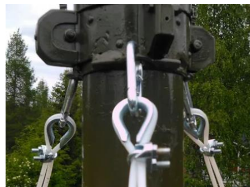
Рисунок 9 – Узлы крепления такелажа для растяжки мачты ВГ.
